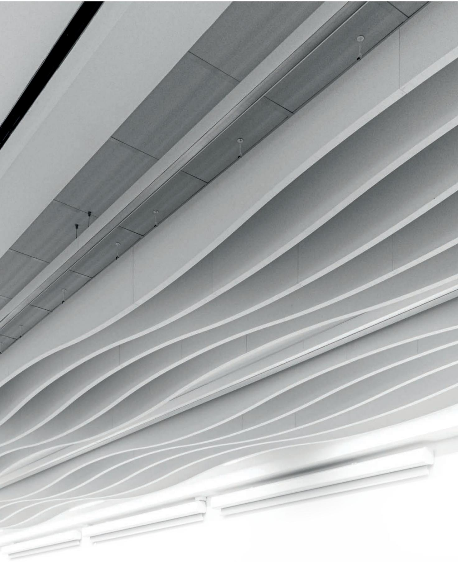
Il nuovo sistema di climatizzazione a diffusione lineare è progettato per essere totalmente integrato con scenografiche linee di illuminazione continue incastonate tra gli eleganti pannelli Ecophon Solo™ Baffle e Ecophon Solo™ Baffle Wave che, oltre ad assicurare eccellenti risultati acustici, trasmettono plasticità e dinamicità a tutto l'ambiente.
